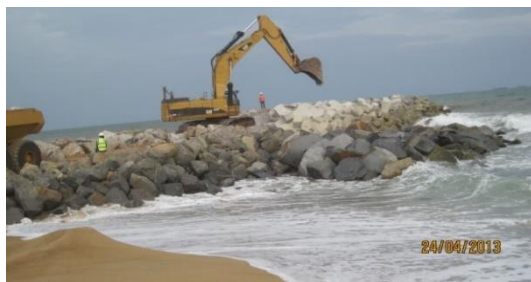
Photo 1 : Une des étapes de construction d'un épi Photo 2 : Epi perpendiculaire à la côte
