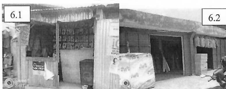
Planche 3 : Vue partielle de quelques boutiques affectées par le déguerpissement
