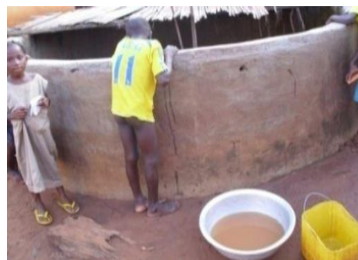
Photo 2 : Trou à eau réalisé à « Aizankon » : (Façade extérieure) Cliché : BAGBONON, Mars 2014
