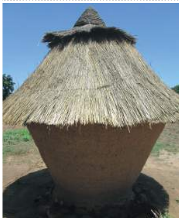
Figure 06. Photo de grenier amélioré en terre fermé
