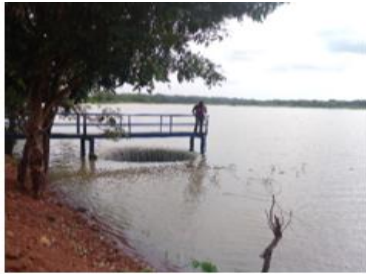
Photo 1 : Déversoir sous l'eau
