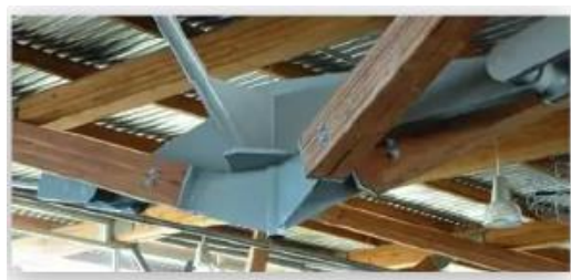
Figure 2. 38: Assemblages mécaniques
