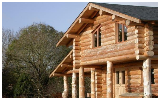
Figure 2. 28: Construction en bois massif empilé
