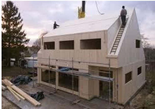
Figure 2. 27: Construction en Panneaux massifs
