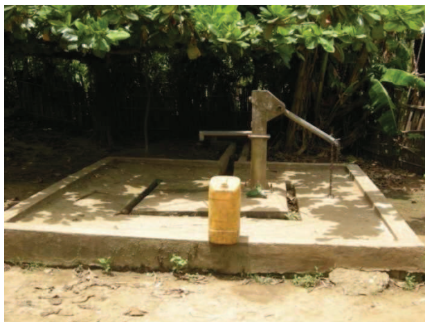
Photo 1 : Forage manuel à Adohoun Cliché : Babadjidé : juillet 2009
