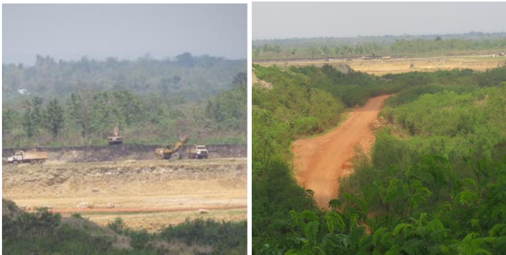
Planche photographique 2 : Espace en exploitation et la voie d'accès à la carrière
