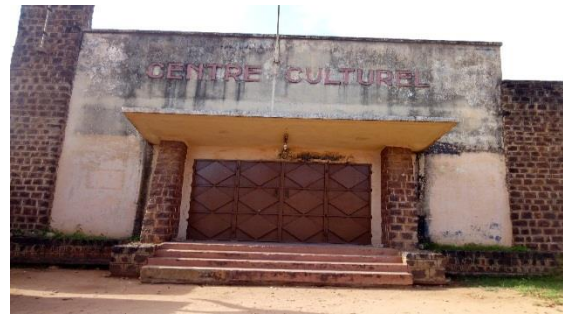
Photo 2: Vue partielle du centre de Jeunes et Loisirs (Ex Centre Culturel) de Ouidah
