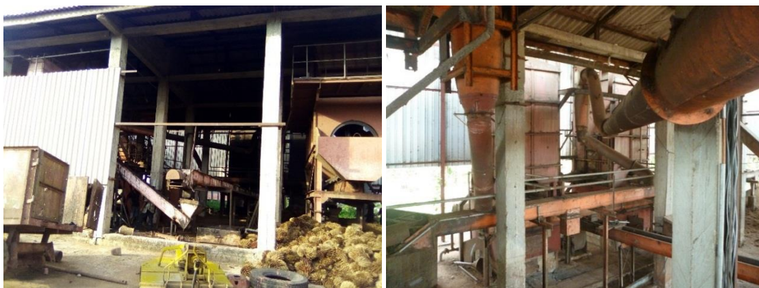
Photo 1 : Aperçu extérieur de l'unité semi-industrielle
