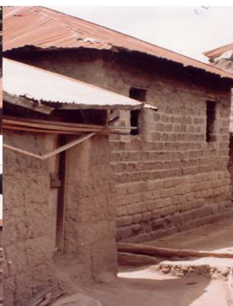
Terre de barre et toit en tôle et mi terre de barre-mi brique, toit en tôle
