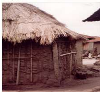
Terre de barre et toit en paille
