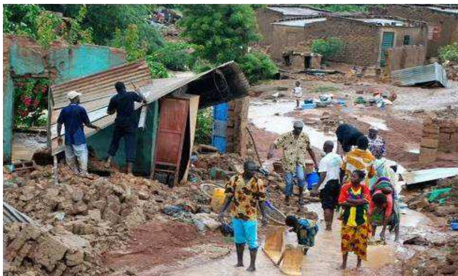
Photo 3. Effondrement d'habitat en banco par ennoyage d'eau torrentiel dans un quartier de Ouagadougou (source PDNA)
