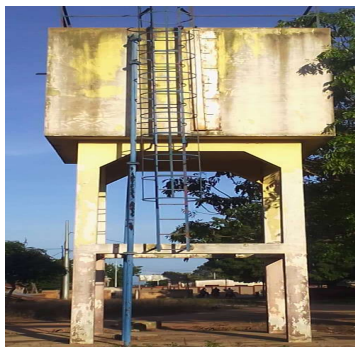
Photo 6 : Château d'eau à Awotrélé
