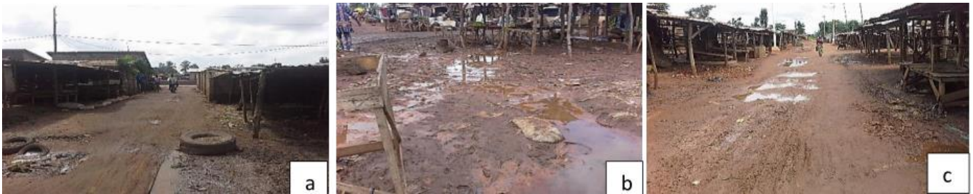
Photo 2 : Etat des voies de circulation entre hangars en saison pluvieuse
