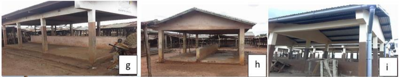
Photo 4: Etat de quelques hangars en matériaux définitifs
