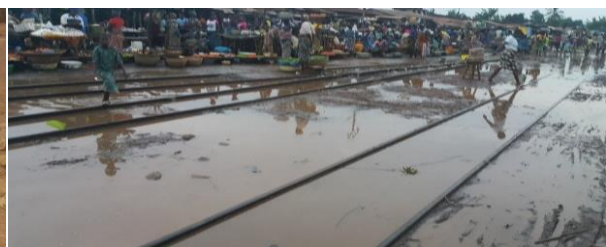
Photo 9 : Inondation du marché au niveau des rails Prise de vue : M. MAKPONSE, septembre 2017
