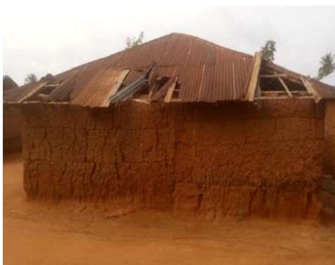
Photo 1 : Vue partielle d'une maison tôlée dans le village
