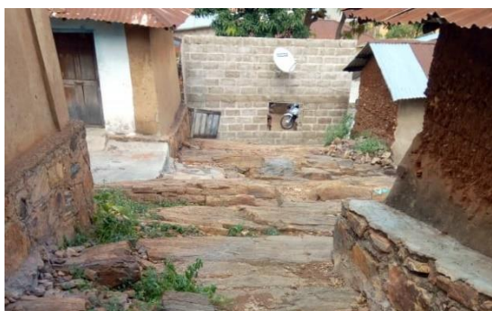
Photo 7 : Soutènement de maison par murette
