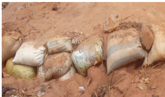
Photo 2 : Des sacs de jute remplis de sable comme moyens de lutte anti-érosive
