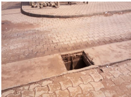
Photo 8 : Caniveau à ciel ouvert à Hassou
