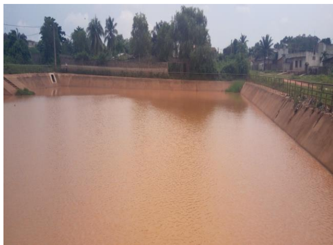
Photo 3 : Bassin de rétention rempli d'eau à Tokpota-Dadjroungbé Prise de vue : Zannou, juillet 2019
