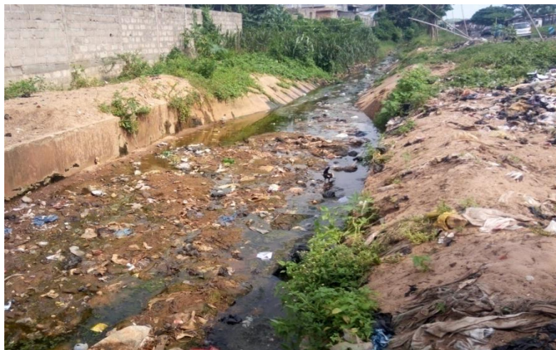
Photo 4 : Vue partielle d'un exutoire à Houéyobgé-Gbèdji Prise de vue : Zannou, juillet 2019
