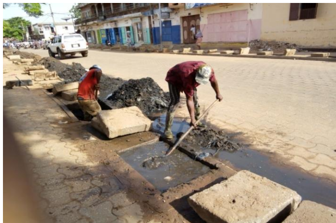
Photo 5 : Curage de caniveau à Kokoyé Prise de vue : Zannou, septembre 2019
