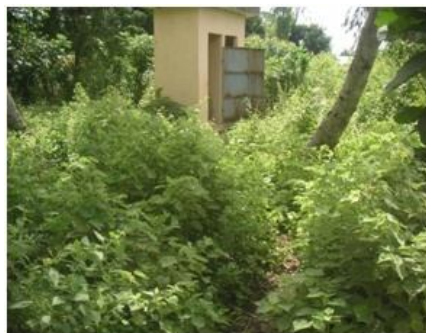
Photo 6 : fosse septique publique mal entretenue dans un environnement insalubre à Madankanmè (Dogbo) (Prise de vue : Sèbo, 2011)
