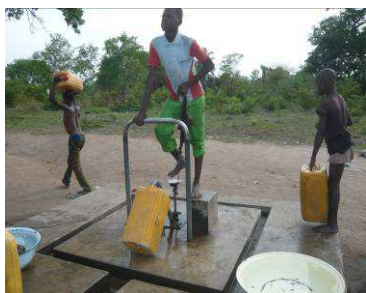
Photo 3: Pompe réalisée à Govi
