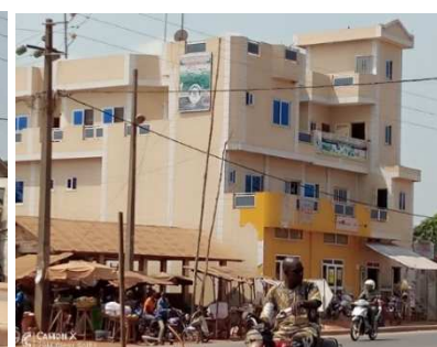
Photo 3 : Habitation moderne de haut standing à Akpro-Misséréte
