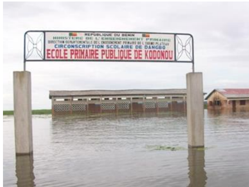
Photo 1 : Quelques dégâts causés par la crue de 2010 dans la BVO
