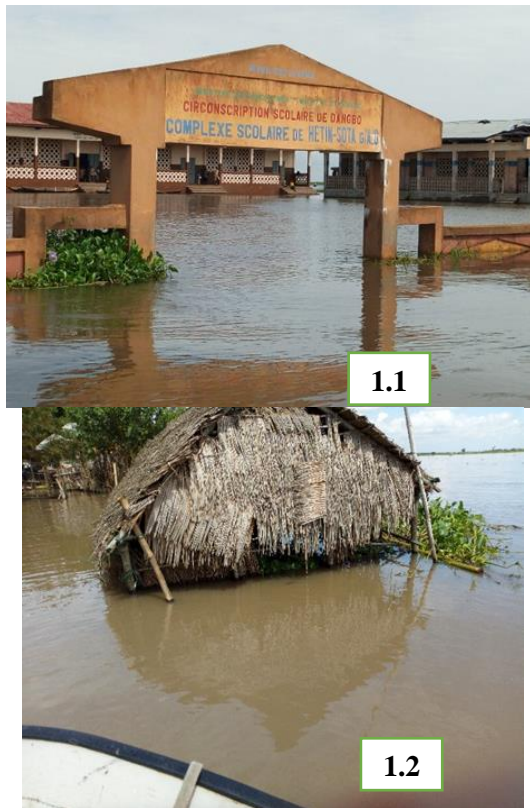
Planche 1 : Quelques dégâts causés par la crue de 2018 à Dangbo
