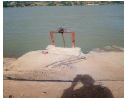
Photo 2 : Digue avec vanne de clapet anti retour à gauche
