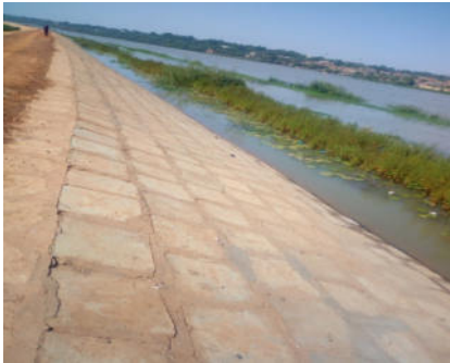
Photo 1 : Digue avec dallettes en béton
