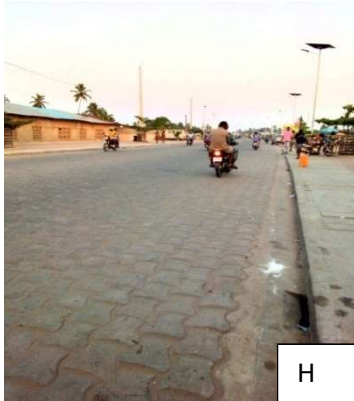
Route en fin de Construction à Djèffa
