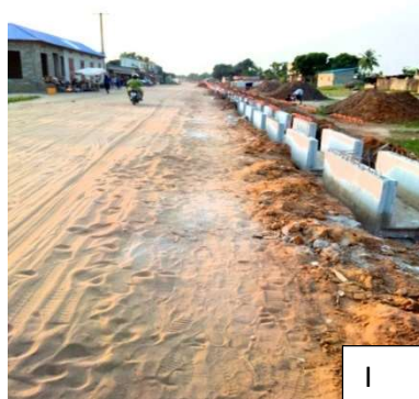
Route en construction de Tchonvi
