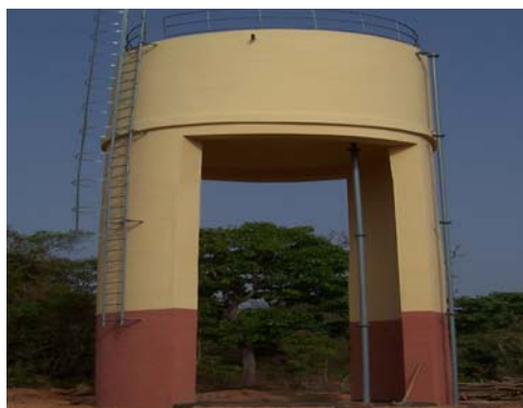
Photo 4 : Château d'eau de l'AEV de Passagon
