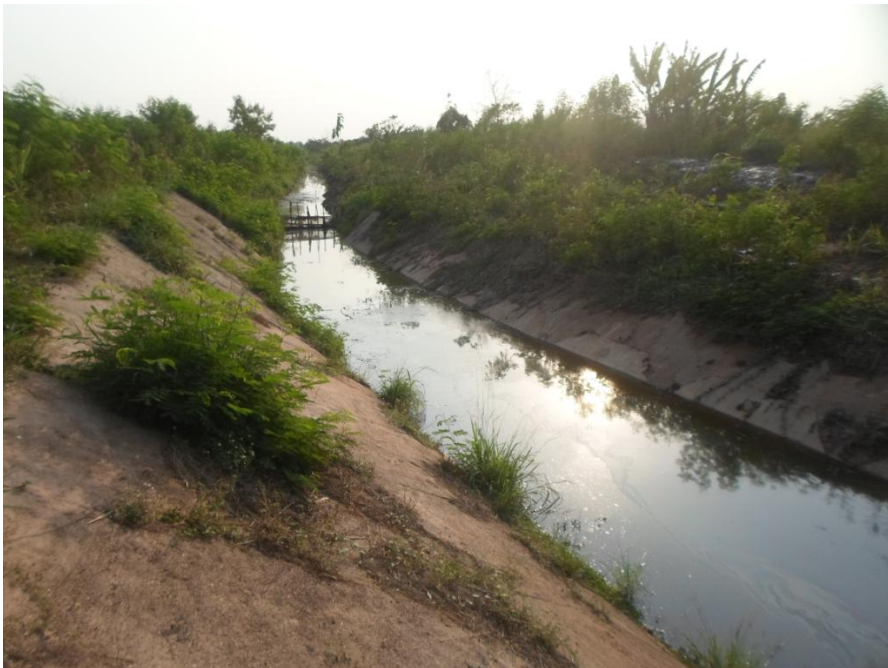
Photo 2 : Vue montrant le collecteur des eaux usées de l'usine. Photo 2 : Sight showing the sewer of the factory used waters.
