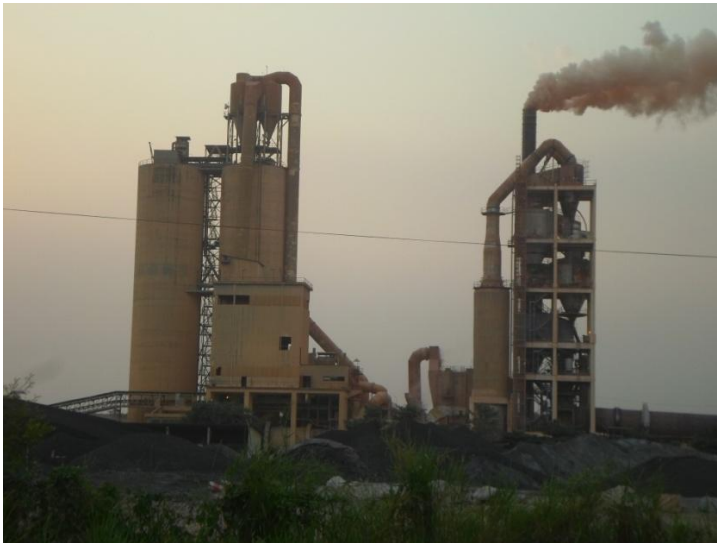
Photo 1 : Vue montrant la poussière rejetée dans l'atmosphère par le broyeur.
