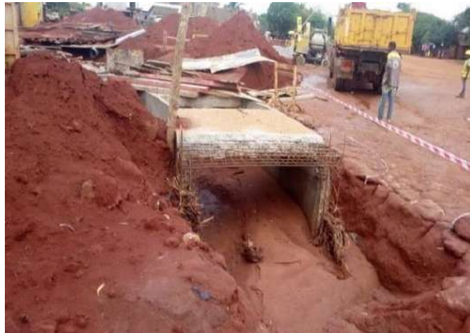
Photo 4 : Caniveau en construction
