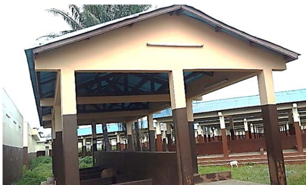
Photo 5 : Hangars au marché d'Aïzè
