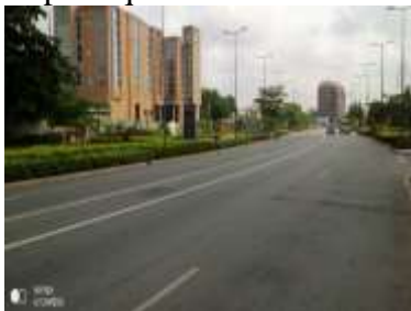
Photo 12 : Rue aménagée carrefour aéroport-Place Amazone
