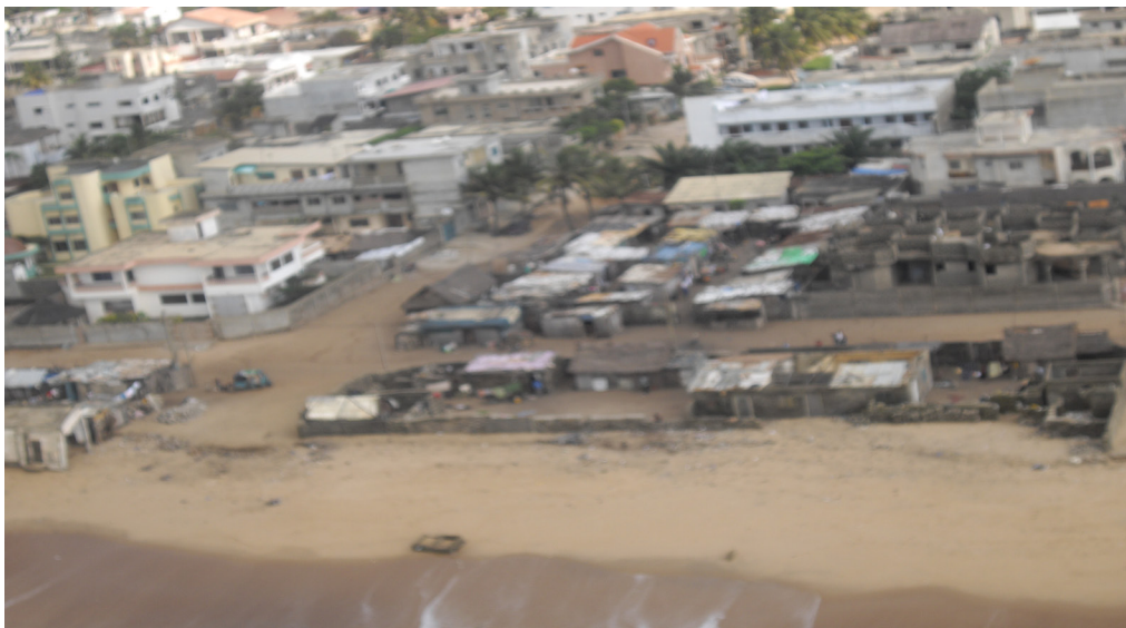
Photo 2: Avancée de l'érosion côtière dans le secteur
