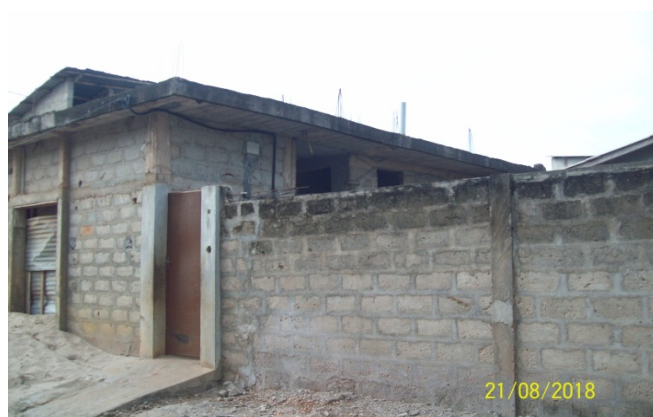
Photo 2 : Vue partielle d'un logement locatif de type moderne en chantier Prise de vue : Kadjegbin Roméo, août 2018
