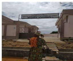
Photo 24 : Passerelle en mauvais état devant maternité d'Akogbato
