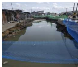
Photo 10 : Stagnation d'eau sur la rue 13414 à Agla
