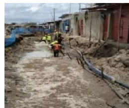
Photo 12 : Eboulement de fouille dans la rue 12887 à petit à petit 2
