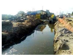
Photo 20 : fouille mal balisée sur la rue 13.341 Gendarmerie Agla
