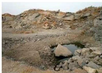
Photo 13 : Dépôt de Déblais en terrain meuble derrière l'aéroport SOGEA-SATOM
