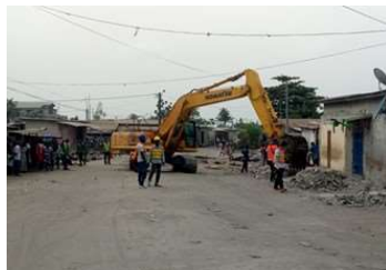
Photo 5: Pelle mécanique entrain de démolir les
