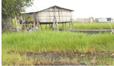
Photo 4 : Maison sur pilotis contre inondation à Sèmè Podji
