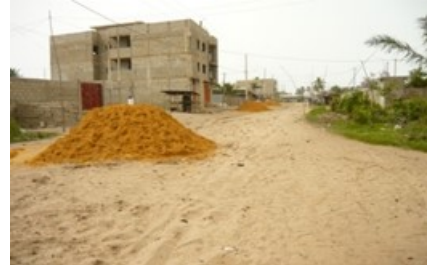
Photo 5 : Surélévation d'un immeuble en construction contre inondation à Sèmè Podji
