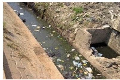
Photo 4 : Curage de caniveau à Sèmè-Podji Prise de vue : Agossou, juin 2020
