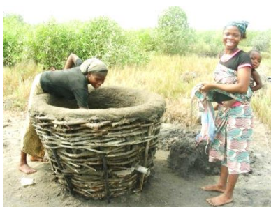
Photo 8 : Fabrication du panier de filtrat
