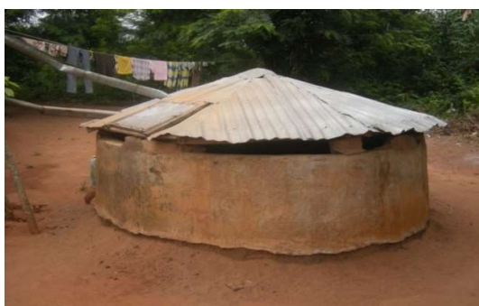
Photo1: Citierne construite dans une maison à Wawata. Prise de vue : Finagnon Abel HOUÉDE, 2015
