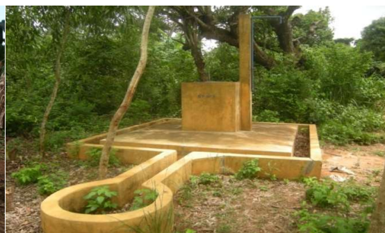
Photo 11: Borne fontaine installée à Houégoudo ; Prise de vue : Finagnon Abel HOUEDE, 2015
