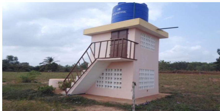
Photo 12 : Poste d'eau autonome en construction à Dangbodji Prise de vue : Finagnon Abel HOUEDE, 2015
