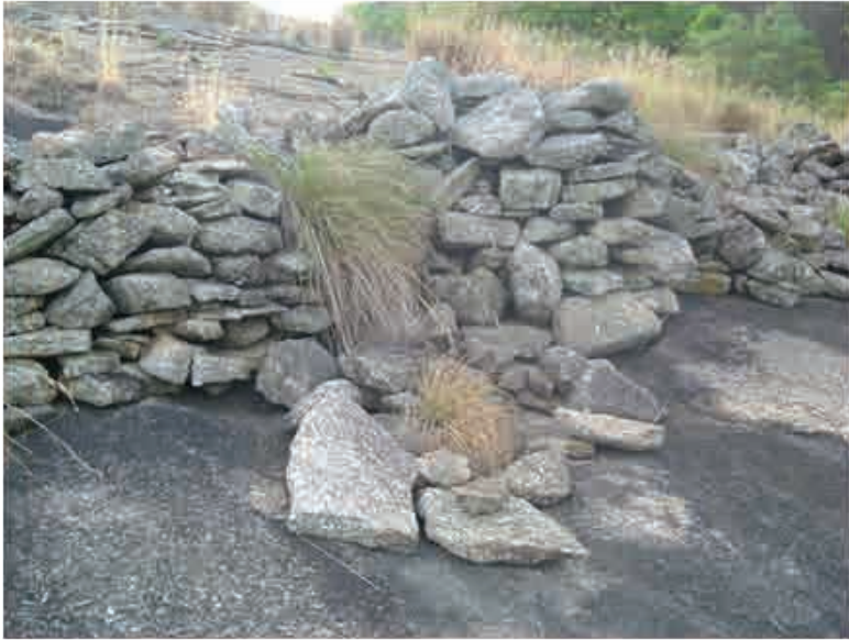
Photo 5 : Restes de structures de fortification du site perché sur la colline de Kabua.
