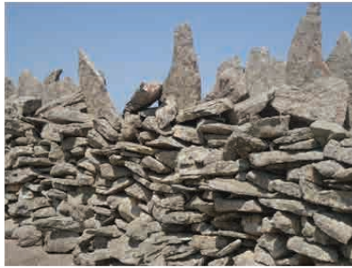
Photo 2 : Vue de détails d'ouvrages de fortification du site d'Abẹkuta
