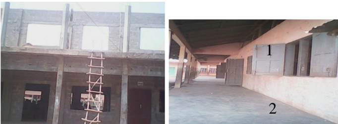
Planche 1 : Quelques infrastructures réalisées avec le concours du financement communautaire
