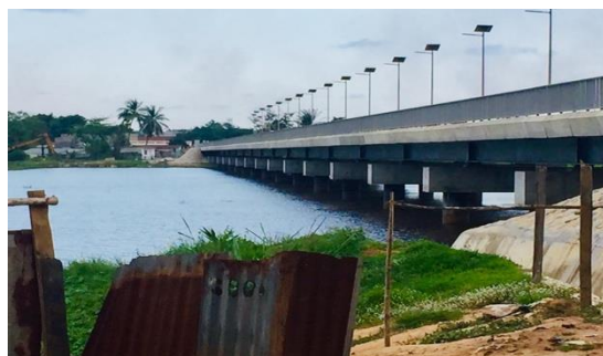
Photo 1 : Vue partielle du pont de Womey.
