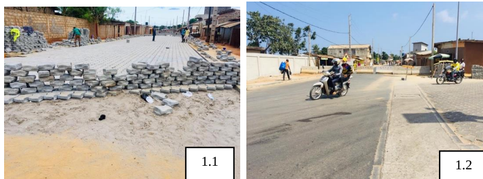
Planche 1 : Vue partielle d'un tronçon de rue en cours de finalisation et un tronçon achevé sur l'axe Ecole Primaire Publique-Bureau d'Arrondissement à Togoudo
