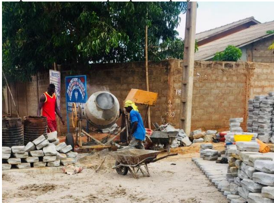
Photo 6 : Employés sur les chantiers à Godomey
