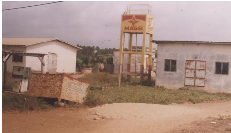
Photo 4 : Station d'essence, atelier de pêche et atelier de fabrique de glace abandonnés à Ayiguinnou
