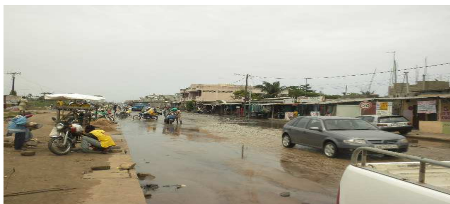
Photo 1 : Inondation des voies pendant la saison pluvieuse
