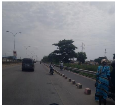
Photo 7 : un motocycliste conduit en sens interdit sur la chaussée à PK 18
