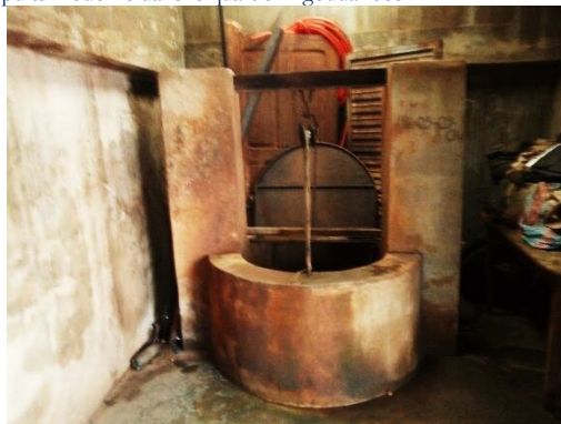
Photo 4 : Puits protégé à Agoudahocon (Prise de vue : Abathan, novembre 2020)
