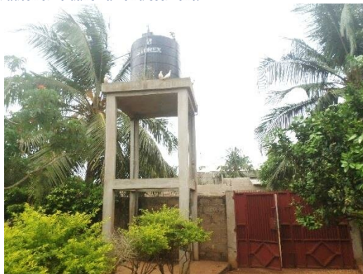
Photo 2: Exemple de poste d'eau au quartier Adjibamè (Prise de vue : Abathan, novembre 2020)
