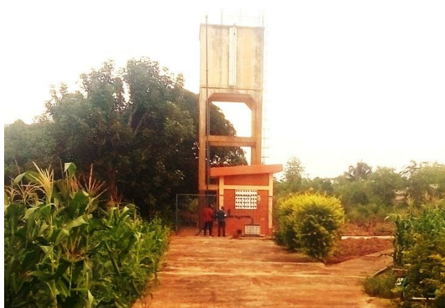
Photo 1: Un exemple d'Adduction d'eau villageoise dans le quartier Aïdjèdo (Prise de vue : Abathan, novembre 2020)
