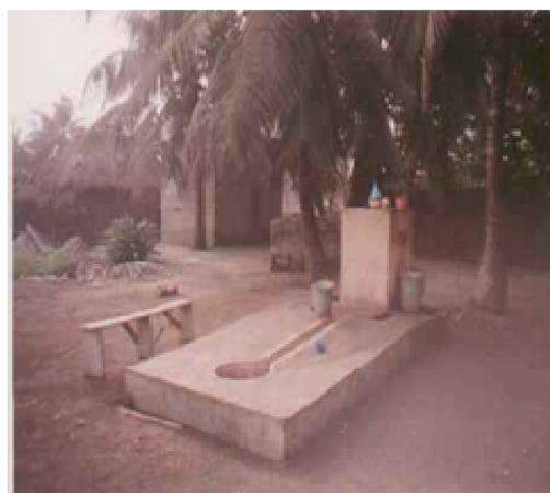
Photo10 : Borne fontaine à Dawé-centre Cliché Hédiblè, 20/08/02
