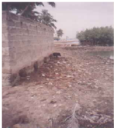
Photo 13: "Latrine à ouverture arrière au bord de la lagune à Djègbadji. Cette flèche indique la présence d'un porc en quête de matière fécale
