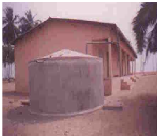
Photo 8 : Citerne servant à recueillir l'eau pluviale à l'école de Djondji Cliché Hédiblè, 04/02/02
