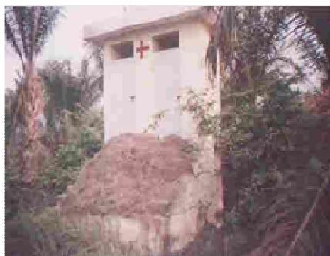
Photo 15 : Latrine publique financée par la croix rouge abandonnée en 2002 à Togbin-Daho ; mais actuellement fonctionnelle. Cette flèche indique un géant tas de sable devant les portes de la latrine ; ce qui prouve que la latrine a été abandonnée.
