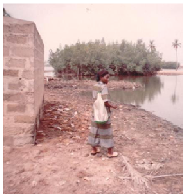
Photo 14 : 'Latrine à ouverture arrière au bord de la lagune à Djègbadji. Ces flèches indiquent que les restes des matières fécales déposées sont charriées par l'eau de ruissellement dans la lagune
