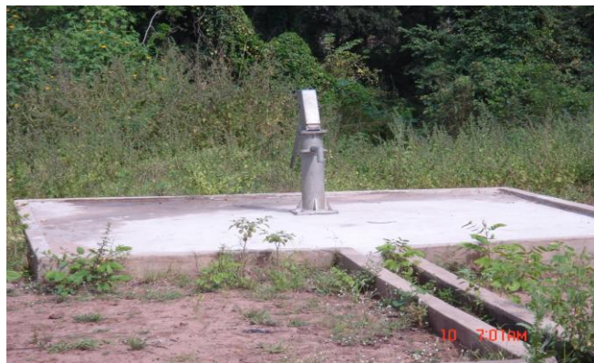
Photo 1 : le forage de Bessé abandonné
