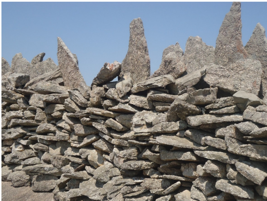
« Muraille en pierres du site ETOO de Yaoui »
