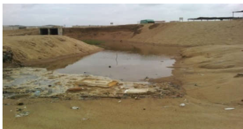
Photo 7 : Collecteur des eaux de ruissellement débouchant sur le littoral Prise de vue : MAKPONSE
