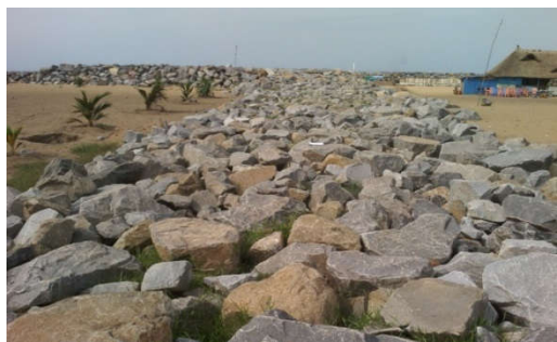
Photo 5 : Epi 1 (prise regard vers le sud) Prise de vue : MAKPONSE, juillet 2015
