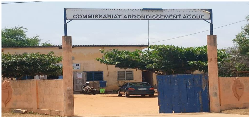
Photo 2 : Aperçu du commissariat d'arrondissement d'Agoué (Prise de vue : ETENE, Septembre 2020)
