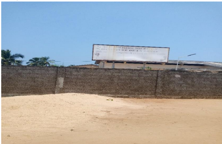
Photo 1 : Aperçu du centre de santé de la ville d'Agoué (Prise de vue : ETENE, Septembre 2020)
