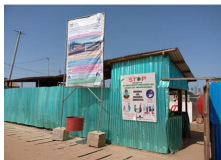
Photo 2 : Rénovation du marché central de Djougou (en cours de construction)
