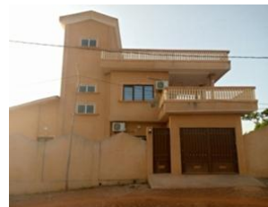
Photo 7 : Maison de type moderne à Leman-bougou
