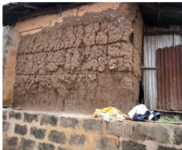
Photo 2 : Ceinturage d'une maison en terre de barre à Adjinan
