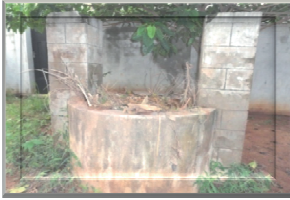
Photo 6 : Puits rempli de déchets solides à Zogbadjé. Cliché DOVONOU F. 2010
