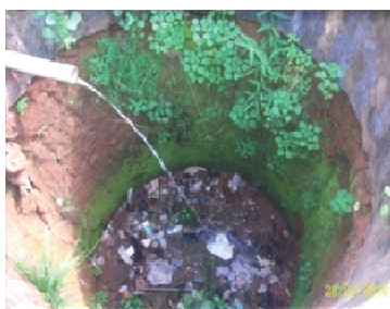
Photo 9 : Latrine non étanche servant à recueillir les eaux usées d'une concession à Zogbadjè (Abomey-Calavi). Cliché DOVONOU F. 2010
