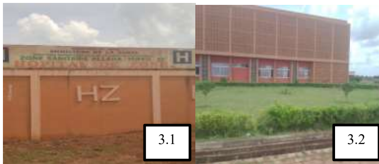
Planche 3 : Vue partielle de l'hôpital de zone d'Allada Prise de vue : Kadjegbin, mars 2022
