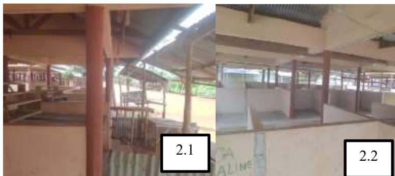
Planche 2 : Vue partielle d'un hangar réalisé par la mairie d'Allada
