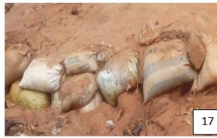
Photos 17 : Usage des sacs de sable contre l'érosion pluviale à Avégodé
