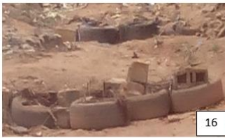
Photos 16 : Usage des pneus usés remplis de sable contre l'érosion pluviale à Dahoué
