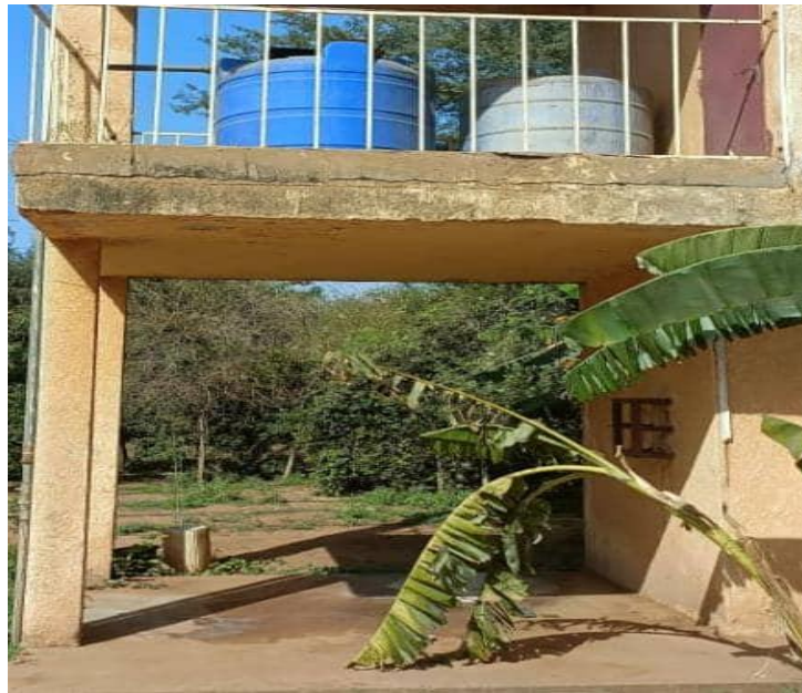
Figure 4 : Réservoirs de stockage
